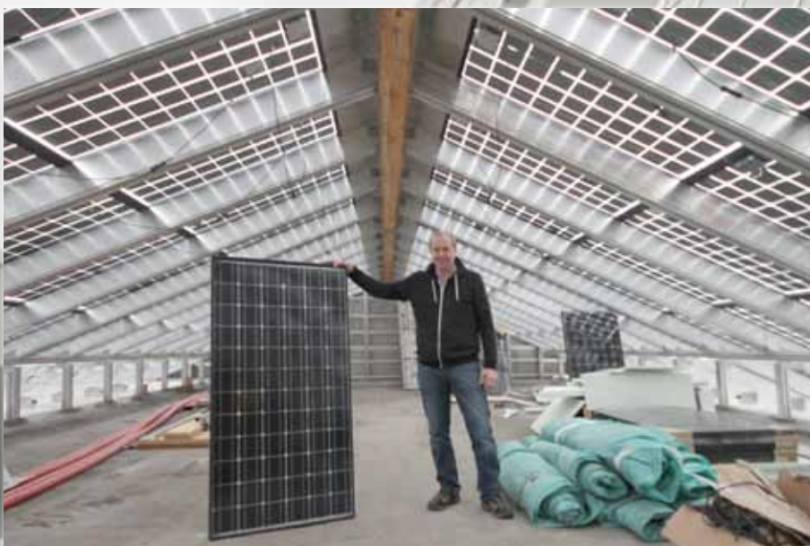
Unter dem Solardach sammelt sich die Wärme und wird mit Hilfe von Wärmepumpen energetisch nutzbar gemacht.
