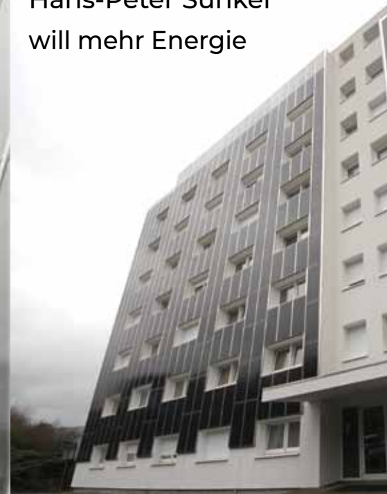
Von außen ist nicht zu erkennen, dass das Gebäude sich einer guten Dämmung mit Photovoltaik-Platten bezieht.
